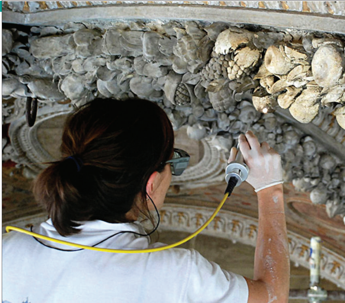
تمیز کاری سنگ با استفاده از لیزر
