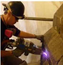
تمیز کاری سنگ با استفاده از لیزر
